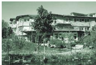
Freie Waldorfschule Köln Architekt: Peter Hübner
